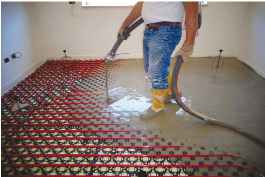
Esempi di impianti a pavimento radiante
